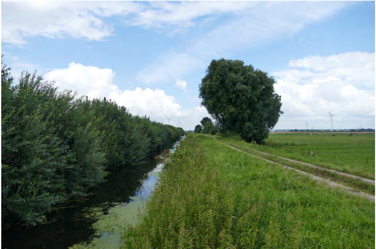
Blick in westlicher Richtung, auf die „Kremper Au“.
